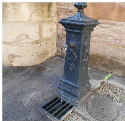
Fontaine d'eau potable à la mairie de Dijon. (LBP Nicolas Durtilly)
